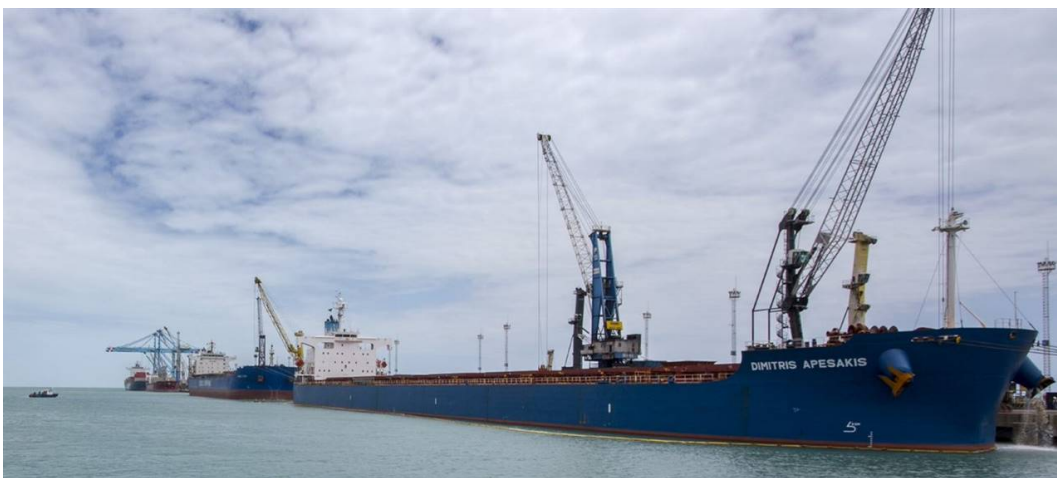
Overslagactiviteiten in de haven van Pecém, Brazilië
