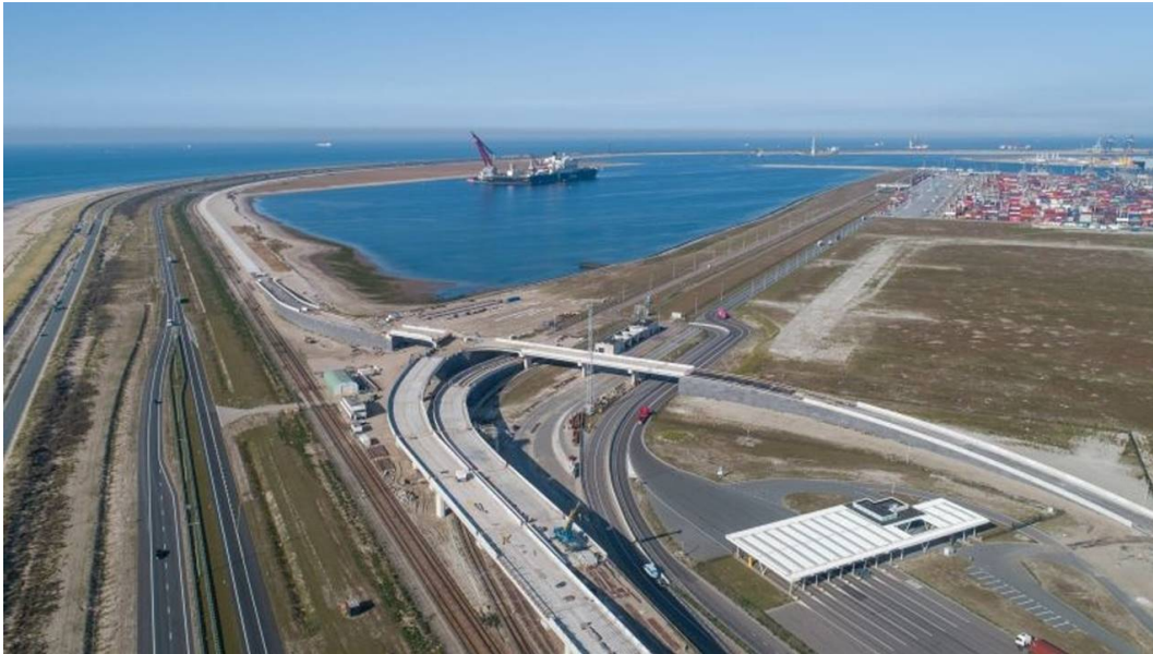
In 2020 vorderde de aanleg van de Container Exchange Route gestaag
